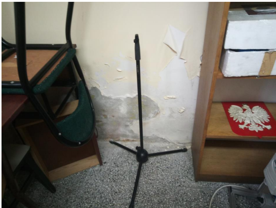
Fot. 10. Stan zawilgocenia ścian przybudówki
