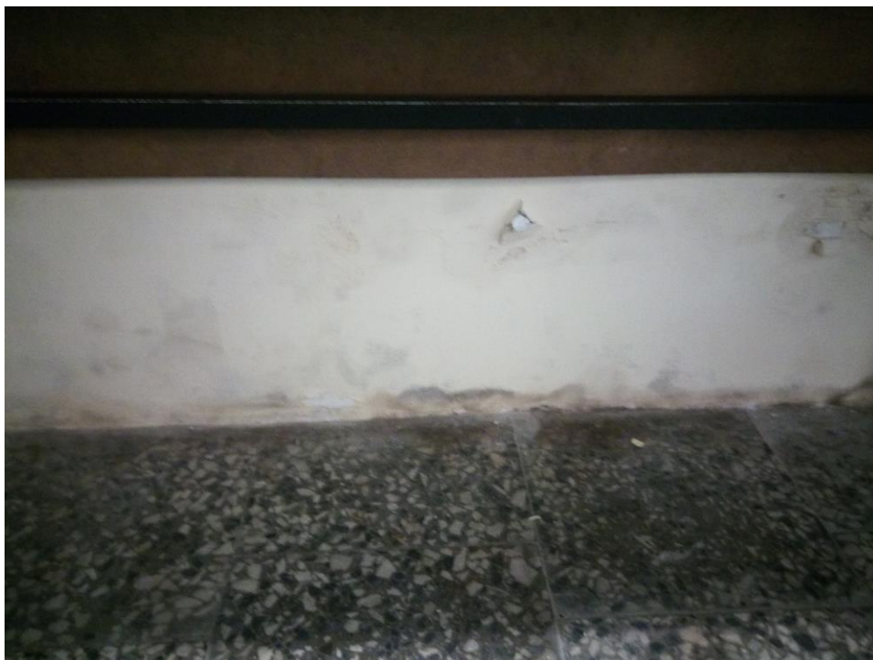
Fot. 10. Stan zawilgocenia ścian przybudówki
