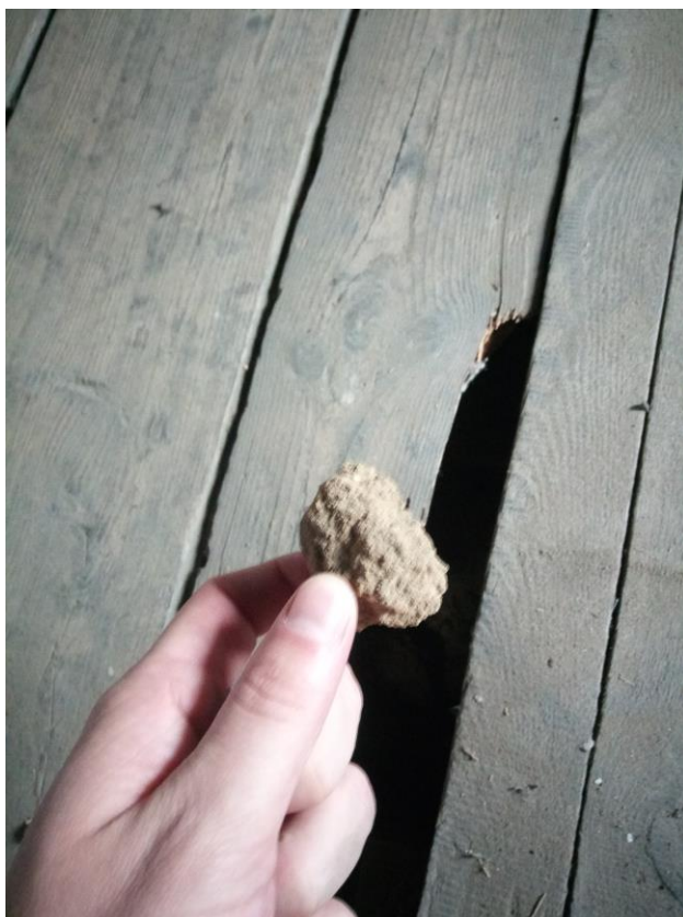
Fot. 8. Istniejący rodzaj izolacji stropu pod nieogrzewanym poddaszem
