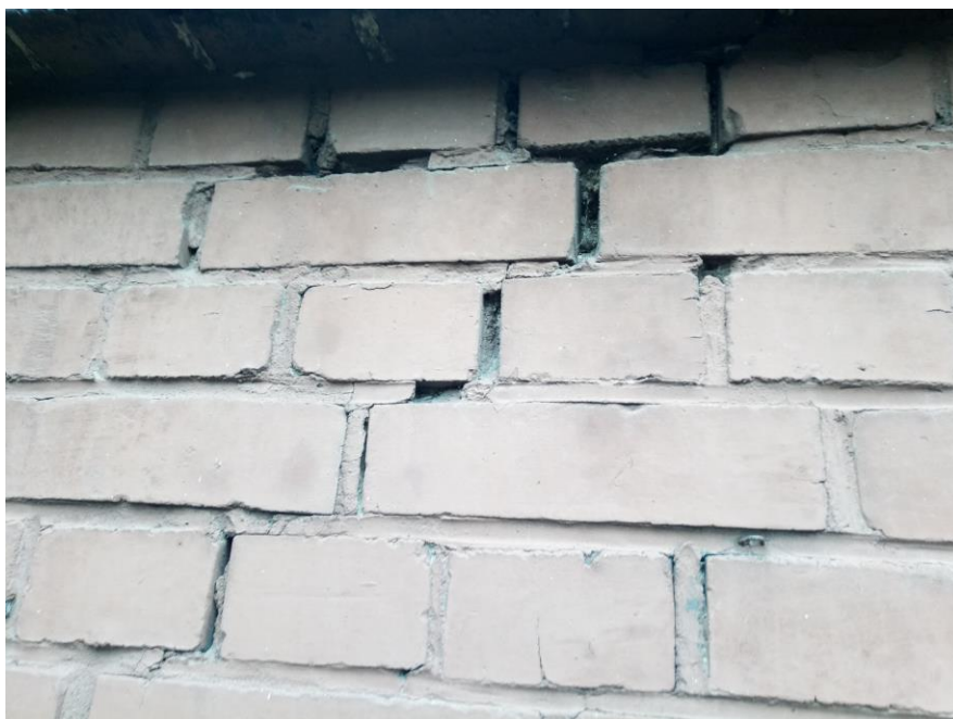
Fot. 6. Przykład spękań, zabrudzeń i ubytków elewacji
